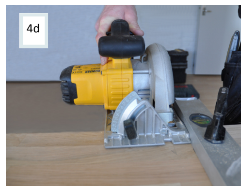
Skær pladen til—altid fra forkant til bagkant for at undgå, at forkanten flænses
